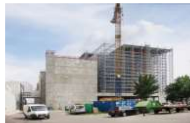
Neubau Hochregallager, Audi AG, Ingolstadt
