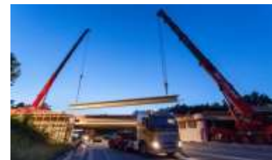
BAB A3, Frankfurt-Nürnberg Teilerneuerung Überführung
