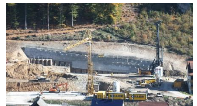
Hotel-Sponsel-Regus, Heiligenstadt, Baugrubensicherung
