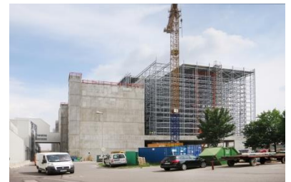
Neubau Hochregallager, Audi AG, Ingolstadt
