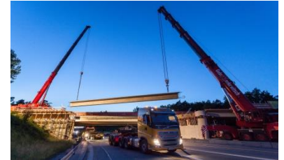
BAB A3, Frankfurt-Nürnberg Teilerneuerung Überführung
